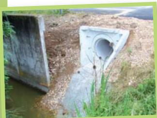
**1** Installation, sous la route, de buses hors d'eau, en parallèle des ouvrages infranchissables.
