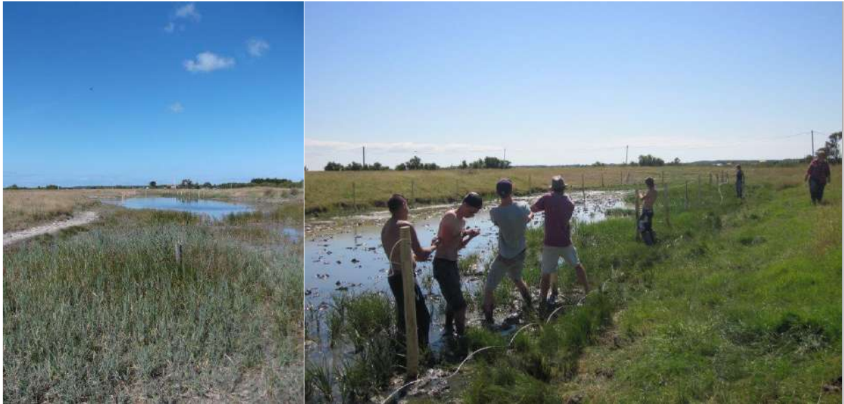
Figure 8 : Zone de scirpaie et chantier de pose de clôture (Photo P. Dulac)
