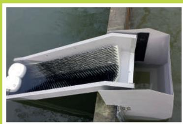
Passes à Anguilles équipée de flotteurs pour suivre les variations du niveau d'eau.
