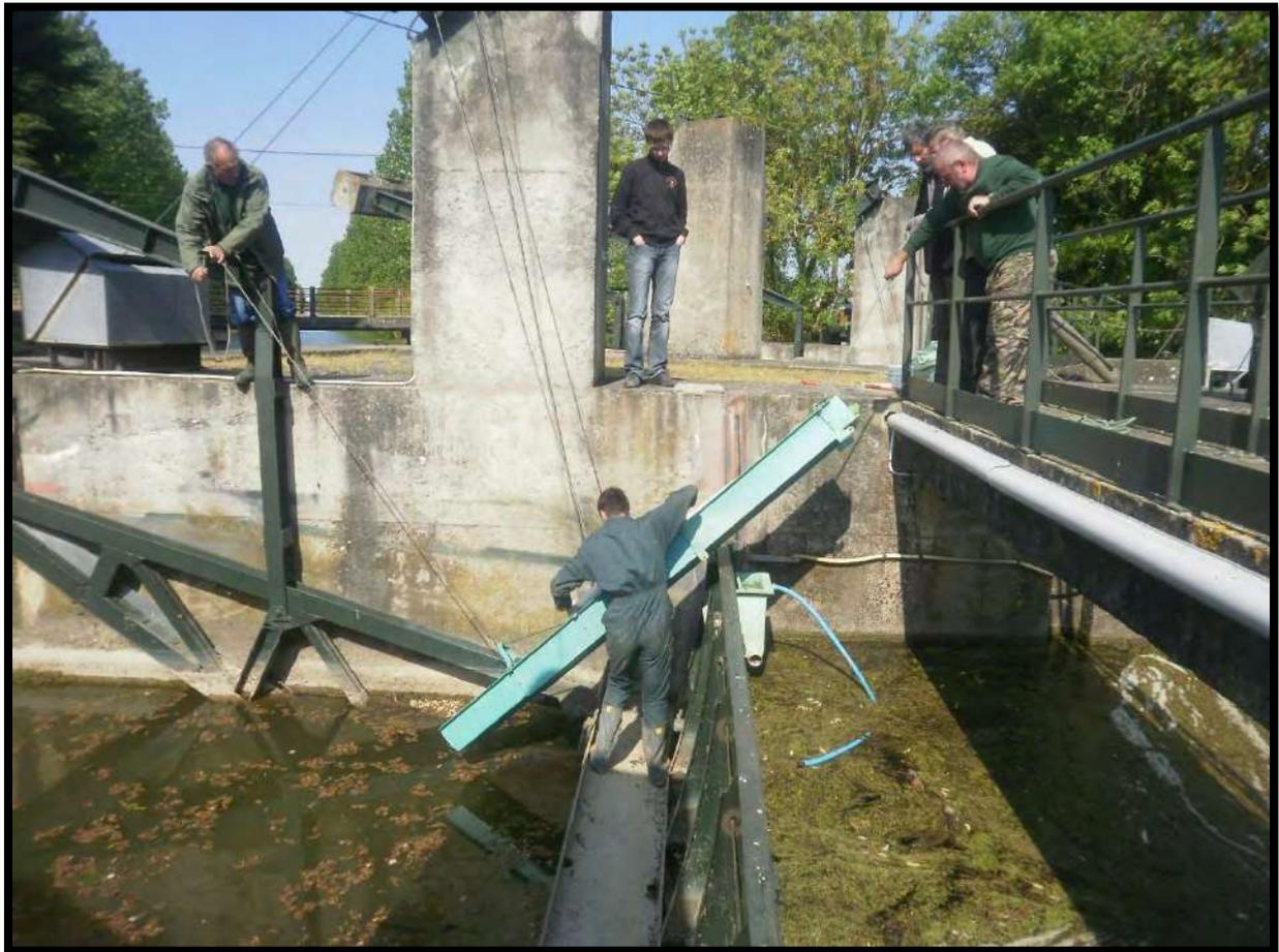
**Figure 6: Installation d'un passe à anguilles sur le barrage de la Boule d'Or, avec la Fédération de pêche 85, M.THOMAS**
