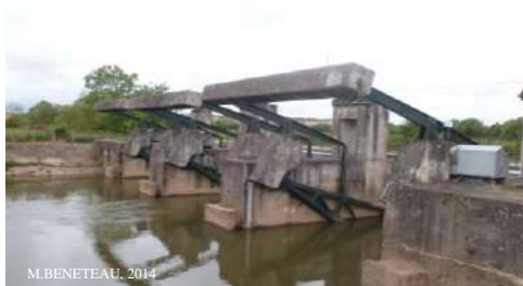
Figure 15 : Barrage de Massigny
