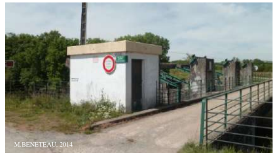
Figure 14 : Barrage de Boisse
