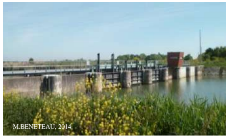
Figure 12 : Barrage Aux Enfreneaux
