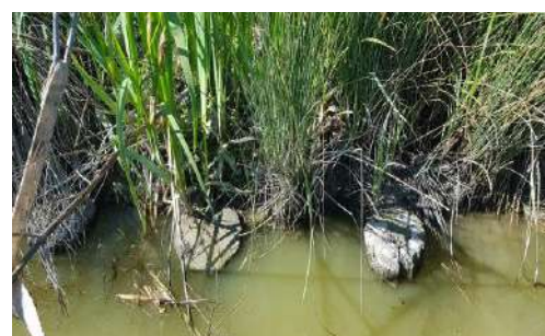
Photographie 5 : Pieux présents sur l'ensemble de la rive gauche du Canal de la Boissière - 2020
