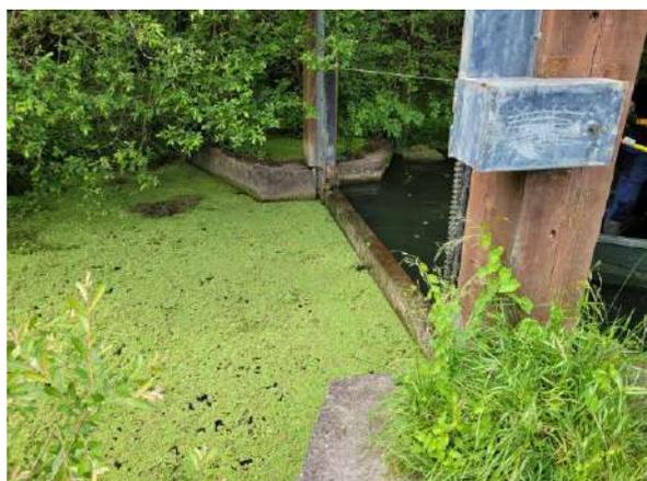
**Photographie 13 :** Vanne de l'Acheneau sur le Canal du Langon, infranchissable pour les anguillettes – 15/05/2023
