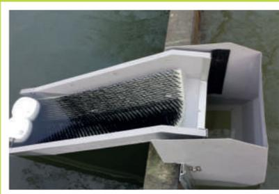
Passé à Anguilles équipée de flotteurs pour suivre les variations du niveau d'eau.
