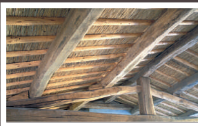
Posé en isolant sous les tuiles
