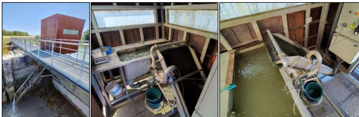
Annexe 5 : Photographie de la Porte des Cinq Abbés (vue aval) (Source : Côme Boudelier)
