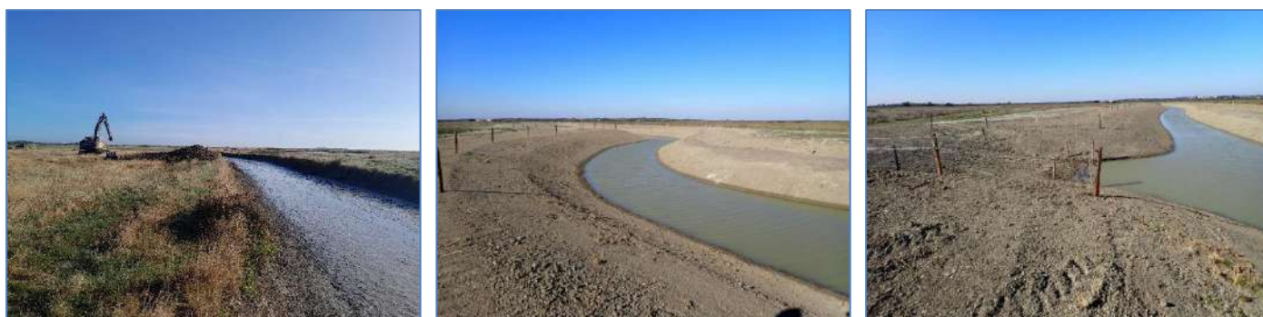
Fossé principal de la réserve de Choisy, avant/pendant/après travaux 2025
