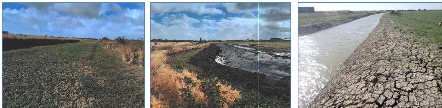
Canal du Bédier, avant/pendant/après travaux 2025
