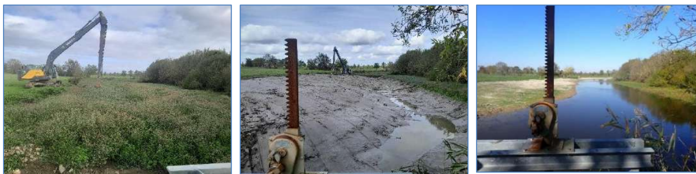
Frayère de la Claye, avant/pendant/après travaux 2025
