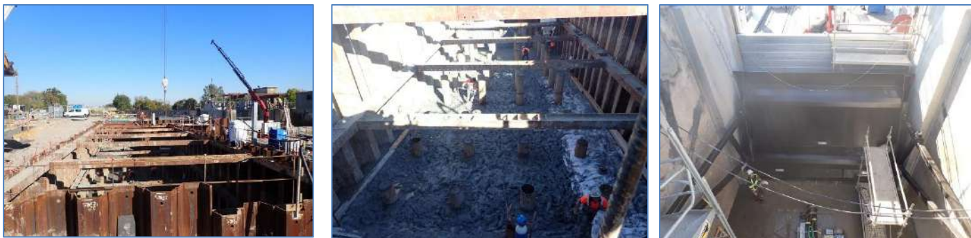
Emprise et fondations de la passe, vanne changée, travaux 2025
